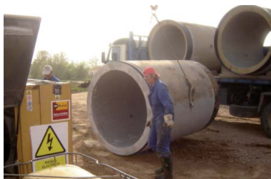
Izado de conducciones.
