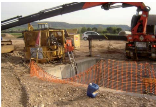
El acceso adecuado al interior del vaciado es de suma importancia.
