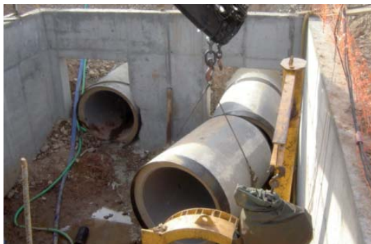
Posicionado de tuberías.
